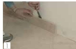
1 Eliminare il battiscopa Remove skirting
