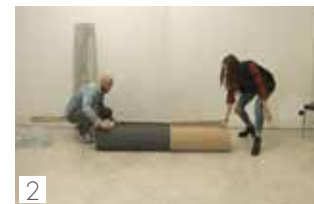
2 Stendere il tappetino Lay the underlayer
